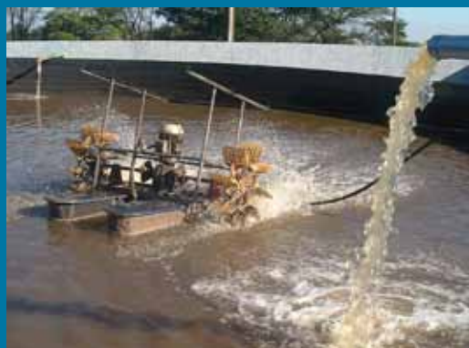
Figura 6 – Tanque de contenção de efluente tratado
